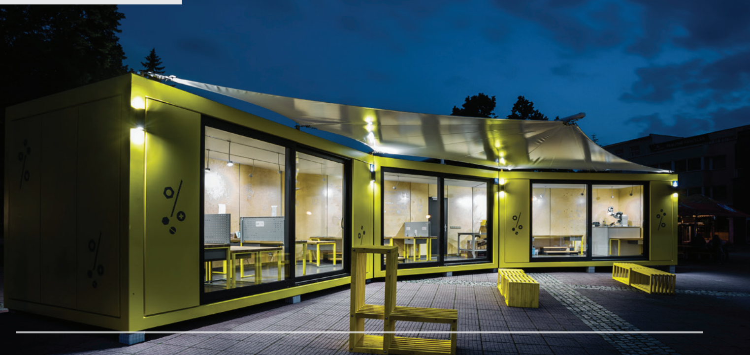
Moderní modulární budova
